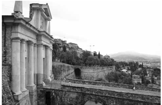
図5 アルタの城壁を出る門 下にバッサが広がっている
