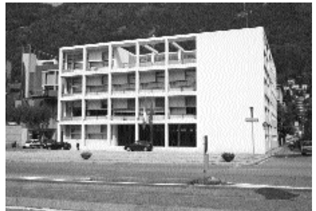
図4 カーサ・デル・ファッショ 格子とカーテンウォールの間にバルコニー分の隙間がある。格子のスクリーン効果が増している
