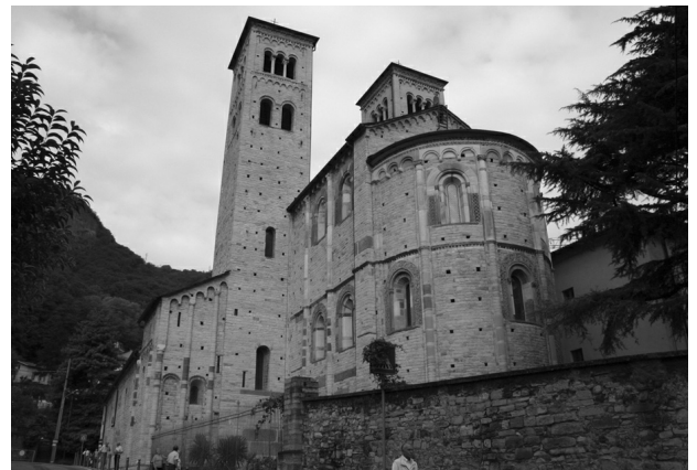
図2 サンタッポンディオ聖堂 ロマネスクの後陣（アプス）と双塔
