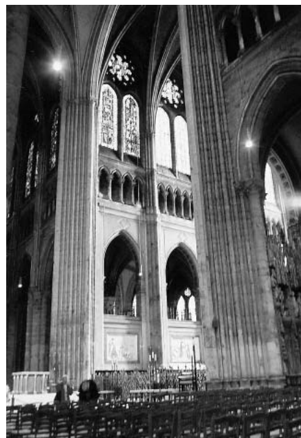
図2 大聖堂交差部 下から大アーケード、トリフォルム、クリアストーリ、リブ・ヴォールトの順で大小の「アエディクラ」が現れる
