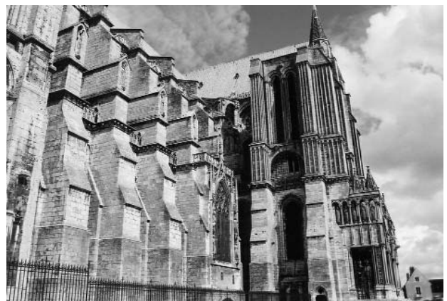
図4 大聖堂南側面 左に連続する控壁とフライングバットレス, 右下がポルタイユ 上に向かって「アエディクラ」が拡大, 増殖してゆく
