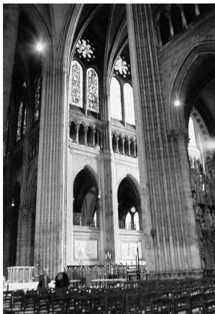
図2 大聖堂交差部 下から大アーケード、トリフォルム、クリアストーリ、リブ・ヴォールトの順で大小の「アエディクラ」が現れる
