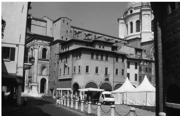
図3 サンタンドレア教会側面 左方にファサードが見えるが、側面は他の建物が覆いつくしている
